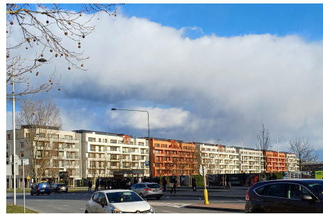
Widok na „falowiec”, marzec 2025 fot. Katarzyna Stoczkowska
